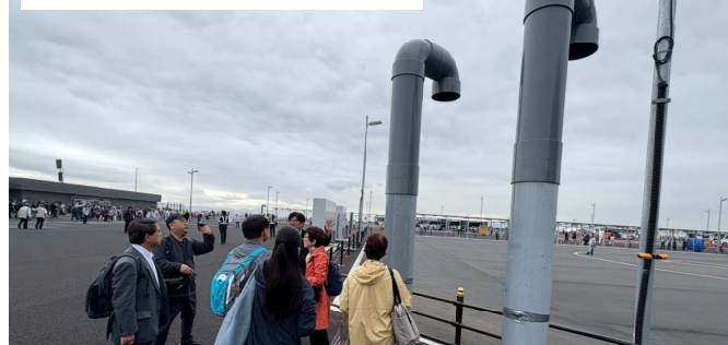
メタンガス対策によるガス抜き管
