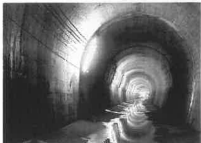
写真 3 導水トンネル
