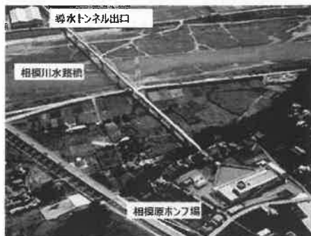
写真 5 相模川水路橋・相模原ポンプ場
