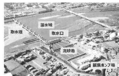
写真2 飯泉取水施設
