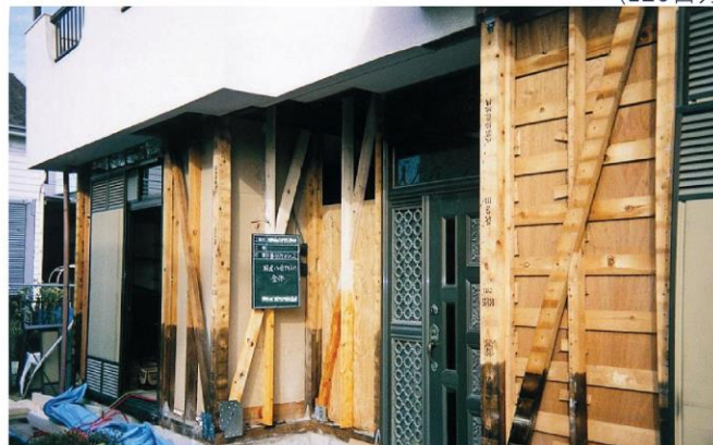
木造家屋耐震補強工事の例
