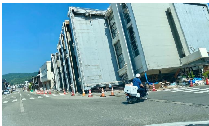
倒壊したビルがそのまま残る輪島市中心街
