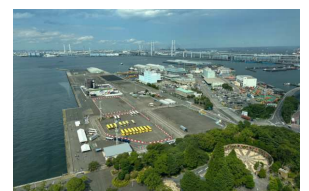
山下ふ頭全景
