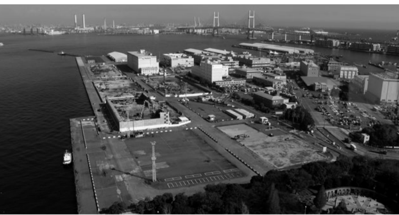
倉庫の解体が進む、自民党がカジノの誘致先として名指しする山下ふ頭(2018.11.16撮影)
