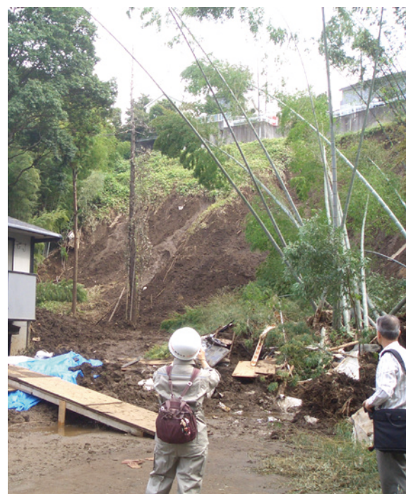
2014年台風18号による土砂崩れで、アパートに土砂が流入し、男性1名が犠牲に。さっそく現場を調査しました。 (2014年10月9日、横浜緑区)
