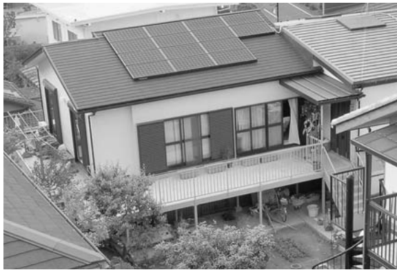
太陽光パネルを設置した大貫憲夫団長宅 青葉区
